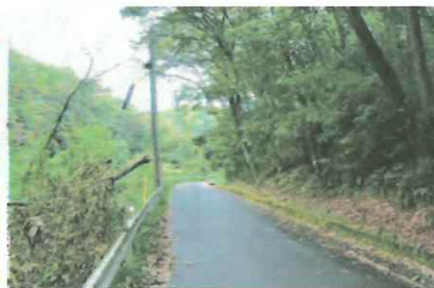
倒木により、道路遮断や電線の切断(ライフラインへの影響)
