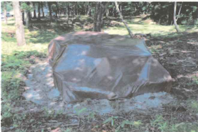
シートで被覆しNCS剤を撒きくん蒸します
